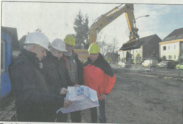
Bauleiter Hans-Jürgen Ehlers, Projektleiter Lothar Richter, Polier Volker Pahl und Straßenbaumeister Axel Koch auf der Baustelle am Rodeland.
